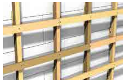
Подконструкции от дърво
